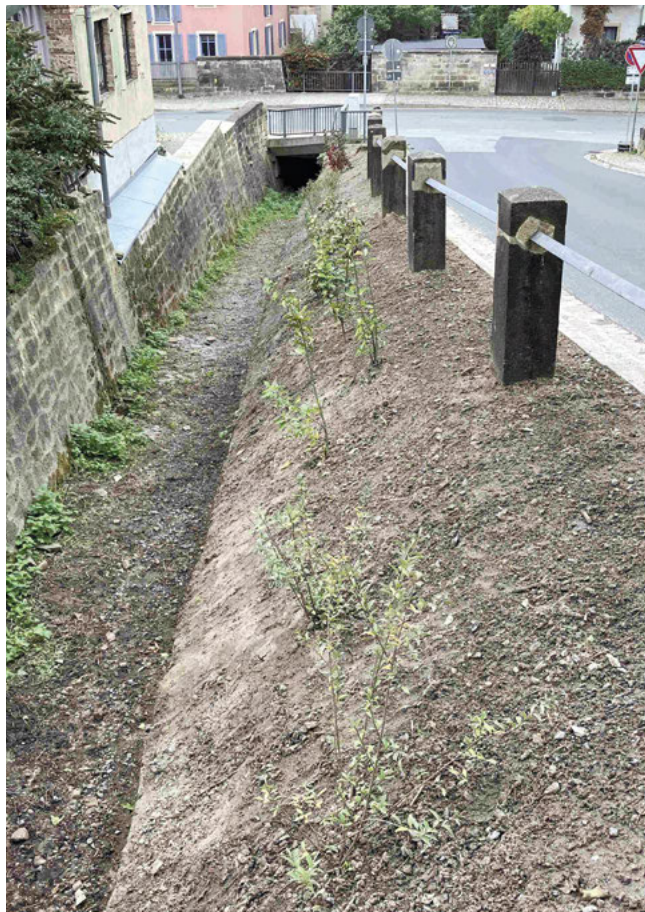
Foto: Uferstreifen am Schumanngraben gleich nach Abschluss der Regulierungsmaßnahme
