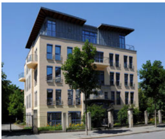
Abbildung 9: Geschäftsstellen- gebäude SSG
