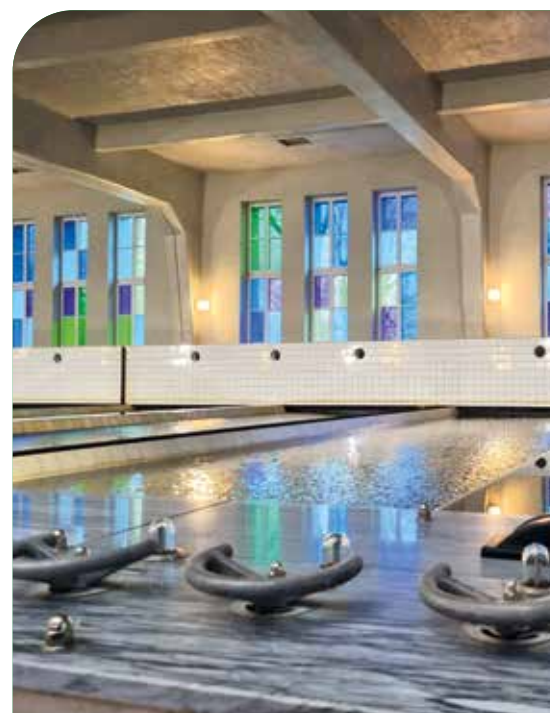
Blick in die Filterhalle Wasserwerk Coschütz
