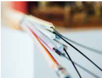
Ausbau TK/Glasfaser ca. 1,7 Mrd. €
